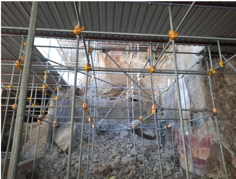
Vista generale del muro interessato dal crollo
