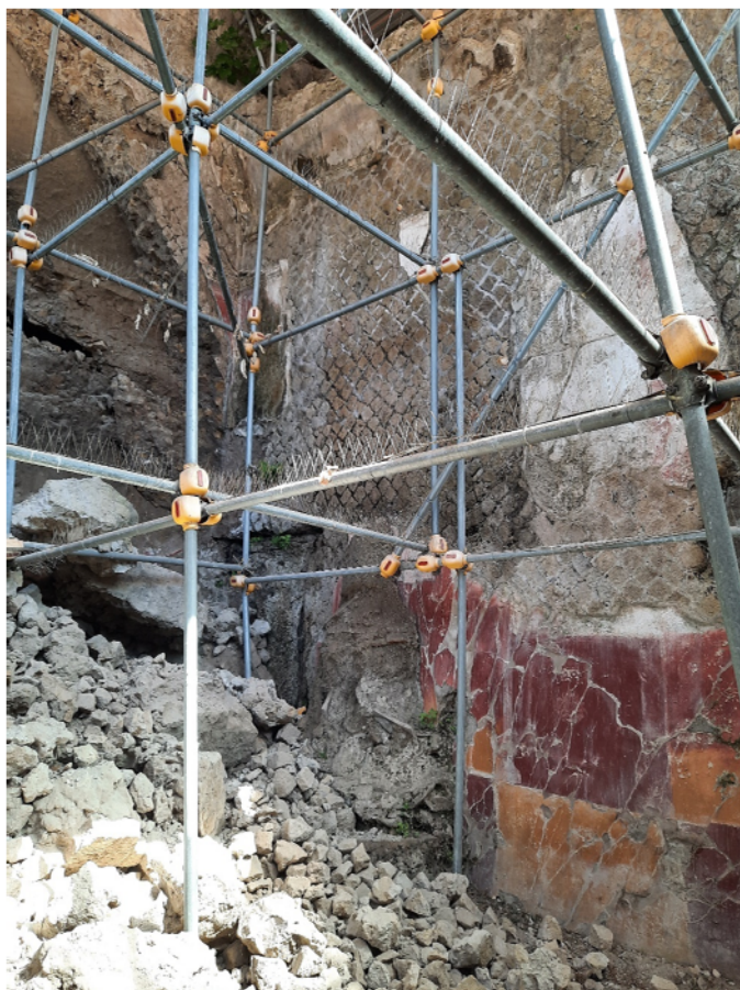
Muro laterale destro con apparati decorativi da mettere in sicurezza e successivamente puntellare
