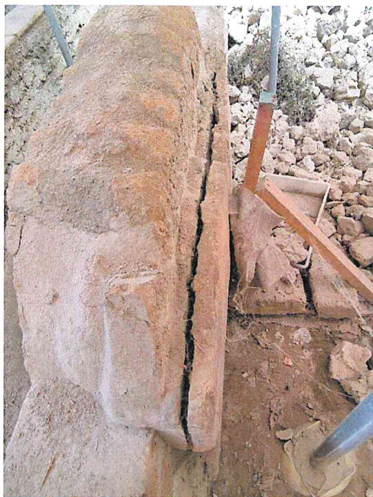
Figura 7 parete ovest_fascia inferiore_distacco pittura murale
