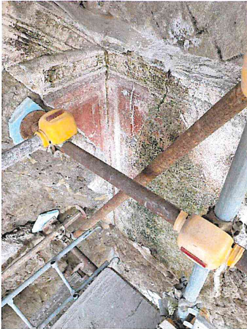
Figura 3 angolo Nord Est_ post crollo_ stucchi e dipinti murali
