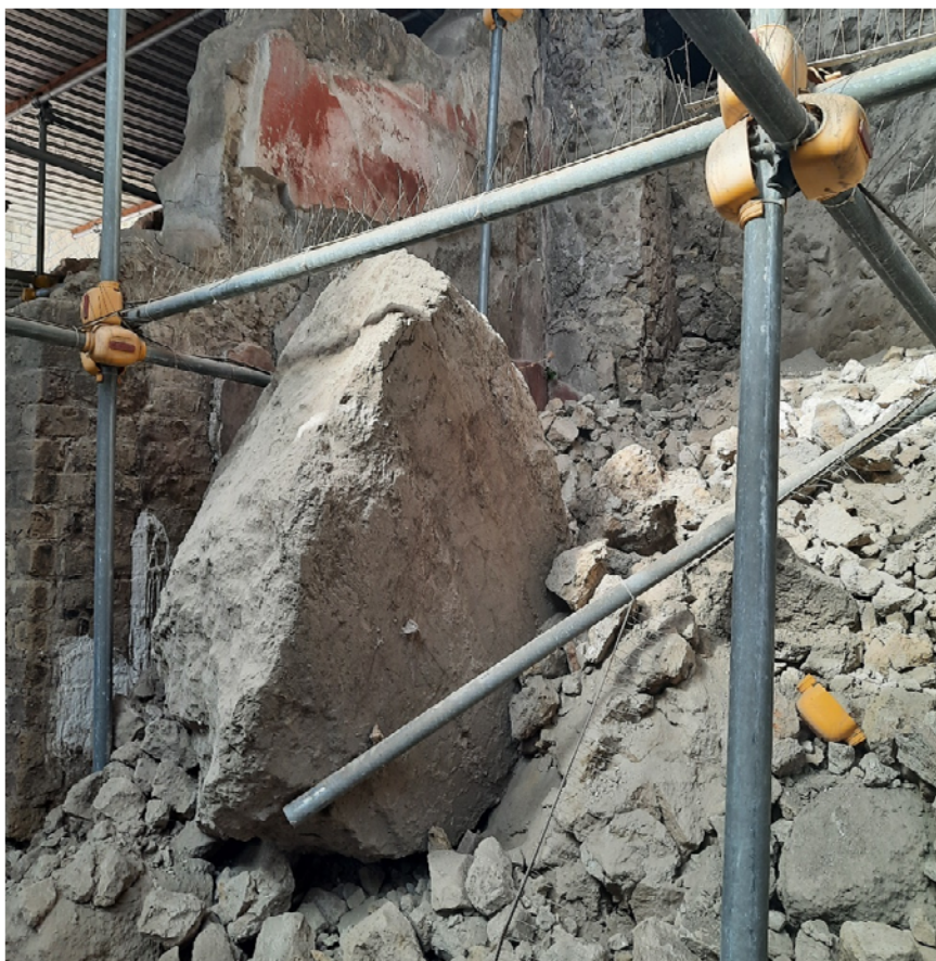
Particolare del masso di materiale vulcanico rovinato dalla parte retrostante il muro, da cui prelevare campione per verificare la consistenza del materiale vulcanico e la stabilità dello stesso.
