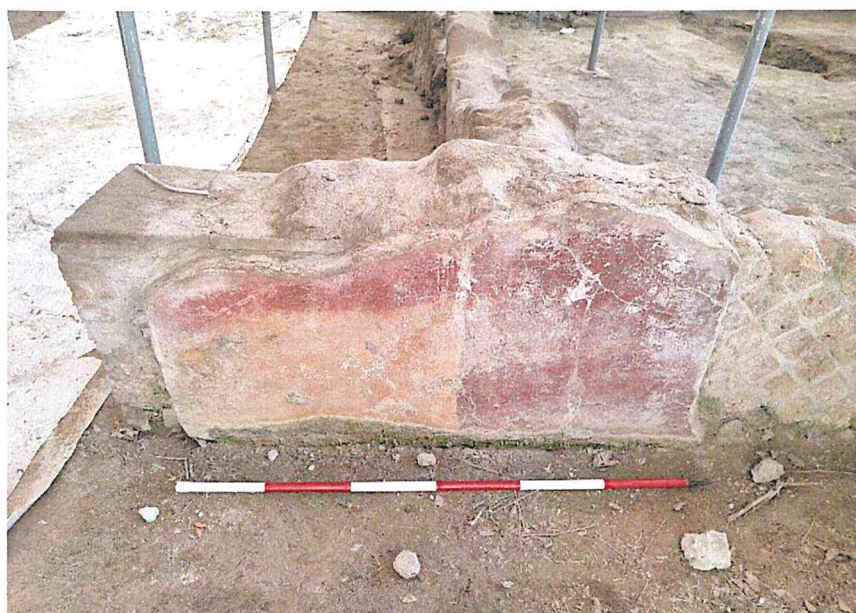
Figura 9 parete Sud_porzione di pittura murale non coinvolta dal crollo
