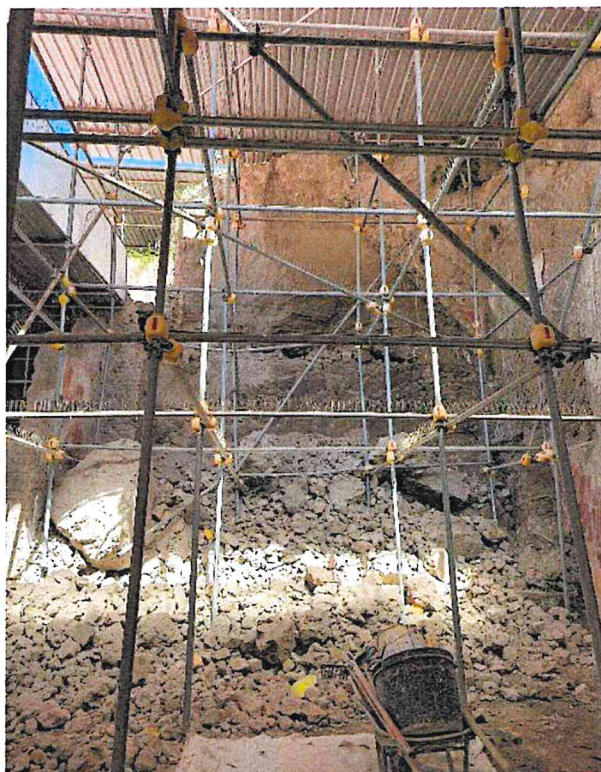
Figura 1 rinvenimento dopo il crollo
